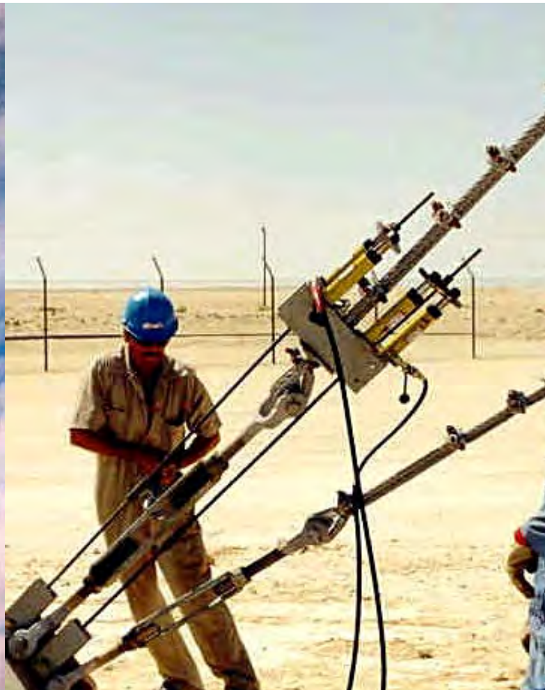
Установка оттяжки
