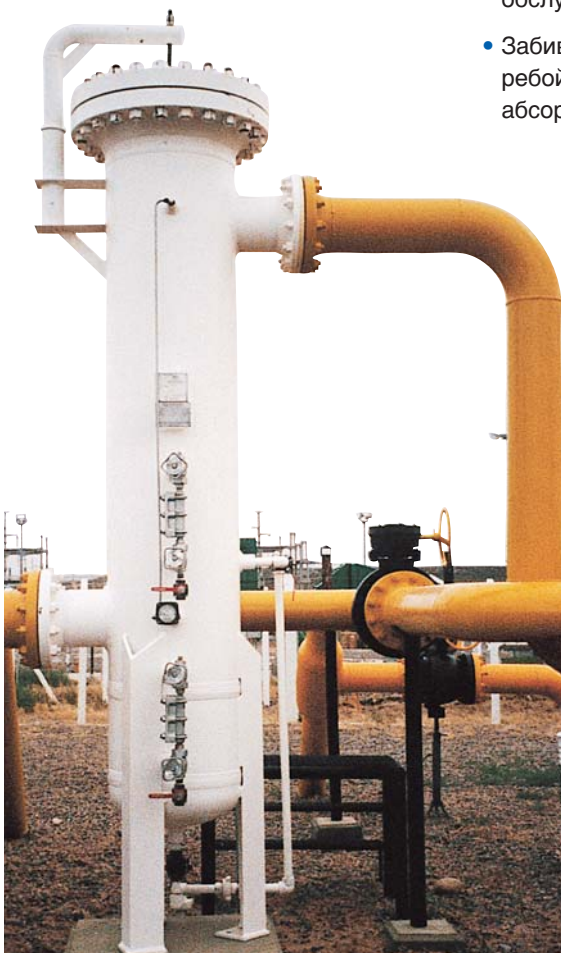
Коалесцер Сепрасол удаляет жидкие аэрозоли из топливного газа турбины.
