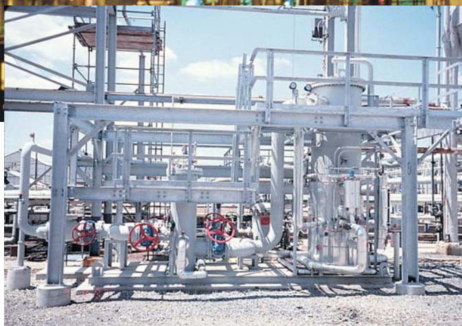
Вертикальная система коалесцеров Аквасеп Плюс Жидкость/Жидкость удаляет воду из авиационного топлива.
