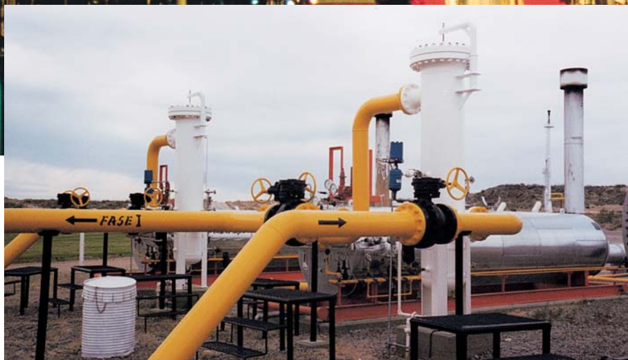
Система коалесцеров Сепрасол Жидкости/Жидкость защищает компрессор.
